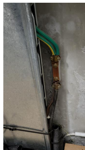
Photos 8 : Barre d'équipotentialité poste de livraison & terre local électrique bureaux
