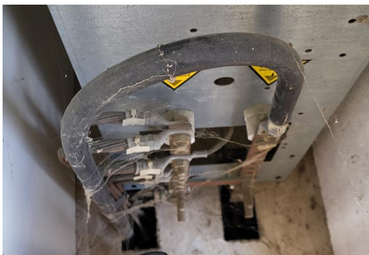
Photos 8 : Barre d'équipotentialité poste de livraison & terre local électrique bureaux
