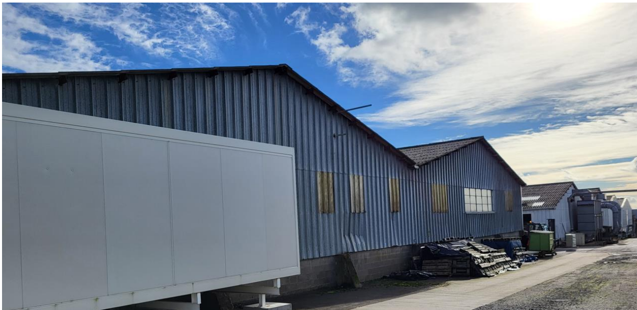
Photo 6 : Arrière bâtiment Montage Emballage & Stock Produits finis
